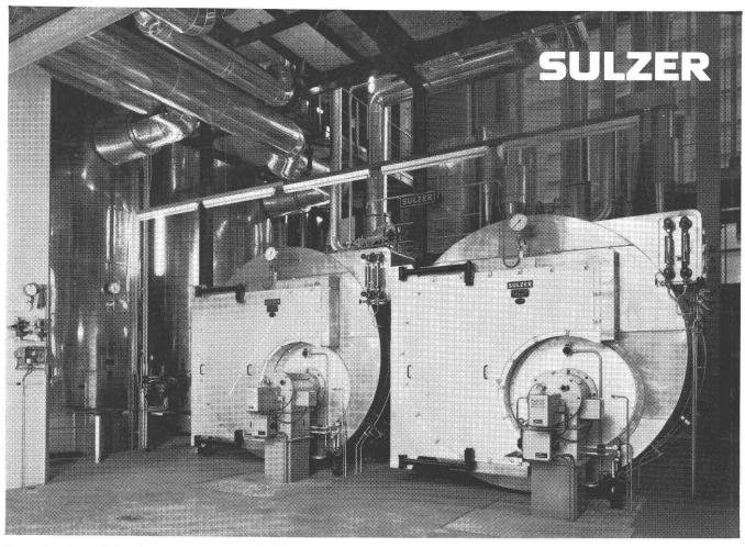
Deux chaudières Sulzer à trois passages avec brûleurs à mazout automatiques dans une usine chimique. Production unitaire 12,8 à 16 t/h de vapeur saturée, pression de service 12 kg/cm²
