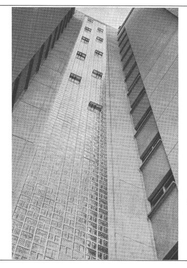
Vitrage en béton armé translucide de grande hauteur (45 m env.) sans entretoises — système breveté Solution esthétique et pratique des vitra-
