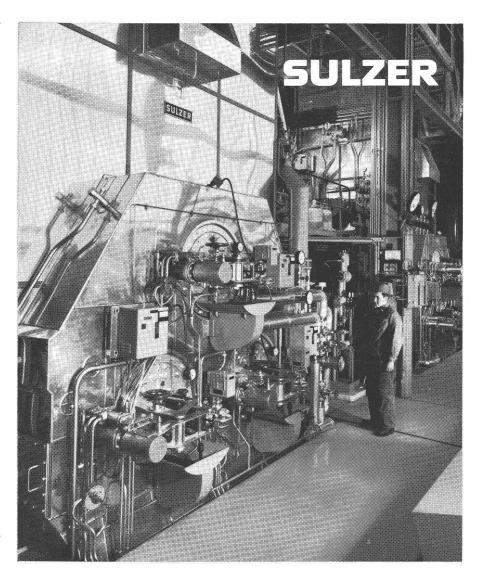
Chaudières à rayonnement Sulzer à haut rendement avec chambre de combustion à surpression et brûleurs à mazout Sulzer. Puissance unitaire 21–26 t/h, 84 kg/cm² eff., 520 °C.
