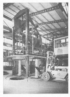
Machine de fabrication des tuyaux.
