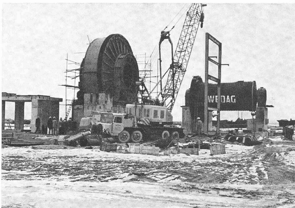
Fig. 6. — Broyeurs du cru en construction.
