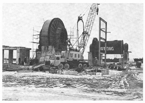
Fig. 6. — Broyeurs du cru en construction.
