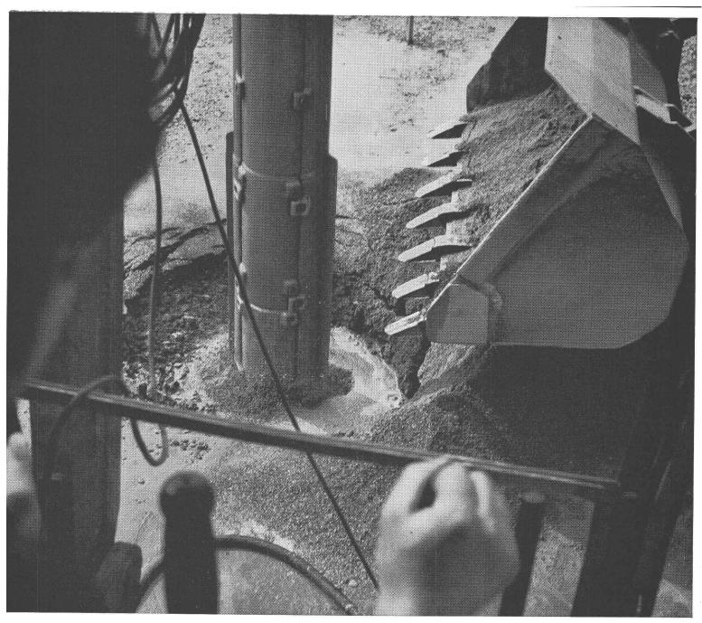
Compactage de sol en profondeur selon la technique de vibroflottation RDV. Elève le taux de charge admissible de terrains naturels ou de remblais artificiels. Réduit le coefficient de perméabilité k des terrains sableux et graveleux.
