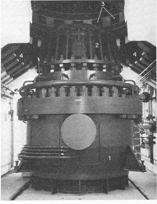
Vanne conico-sphérique disposée sous la pompe-Fig. 11. turbine (vue du côté opposé au servo-moteur de commande).
