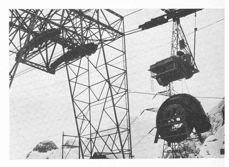
Fig. 4. — Transport d'une bâche spirale par téléphérique Le poids de la bâche avec son support atteint la limite de charge de 20 t. Photo bureau d'ingénieurs MAGGIA 16851
