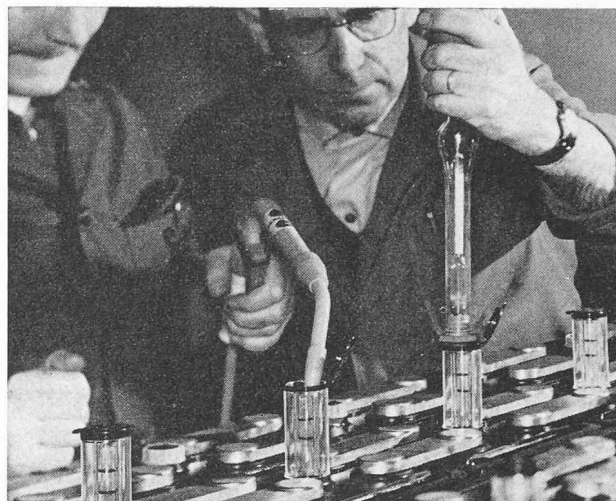
Fig. 4. — Adjonction d'eau distillée et mesure de la densité de l'acide, en employant le dispositif de remplissage Fill-Meter.
