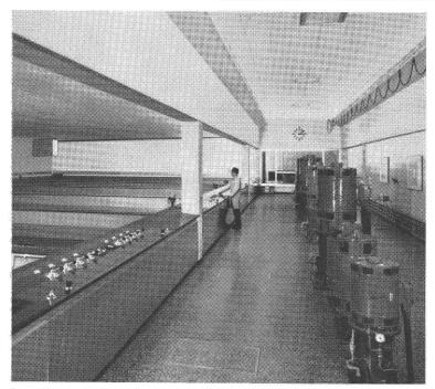
Installation de filtres rapides de Champ-Bougin, appartenant à la ville de Neuchâtel, pour le traitement d'eau du lac en eau potable. Capacité 1800 m<sup>3</sup>/h.
