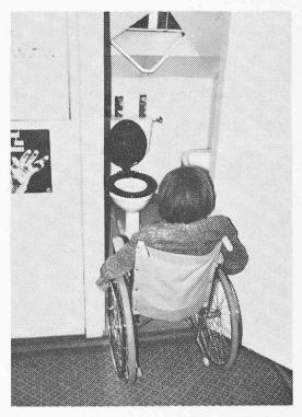
Fig. 3. — Portes de toilettes larges de 65 cm seulement, constituant un obstacle absolument impossible à franchir.
