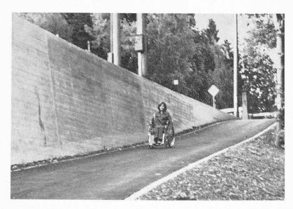
Fig. 4. — Les rampes, pour autant qu'elles sont inévitables, ne doivent pas avoir plus de 6 % de déclivité.
