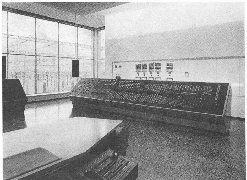
Fig. 3. — Répartiteur de charge et régulateur de réseau du poste de couplage de Chamoson.
