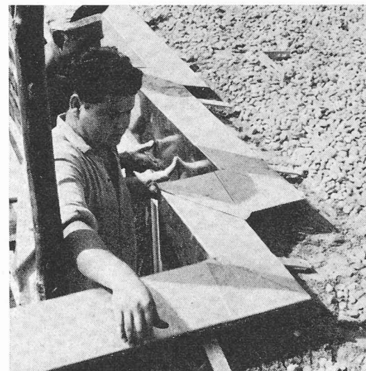
Pose des cornières de support préfabriquées
