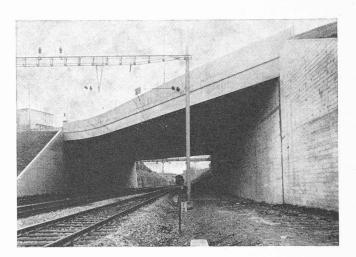
mode d'exécution, déterminé déjà au stade des études. Tous les travaux furent en effet exécutés sans interruption du trafic routier et sans ralentissement sur les quatre voies CFF, celles-ci étant franchies sans appuis intermédiaires, même pendant la construction du pont.
