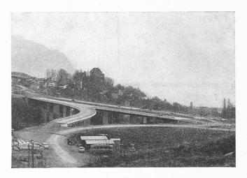
fond a une épaisseur constante de 15 cm; les entretoises d'appui, de 1,00 m d'épaisseur, assurent l'encastrement tablier sur les palées.
