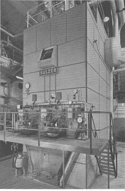
Chaudière à rayonnement Sulzer à haut rendement, avec foyer pressurisé, installée dans une fabrique de carton; production 16 à 20 t/h, 41 kg/cm², 425 °C. Plate-forme de service avec deux brûleurs à mazout Sulzer de chacun 800 kg/h.
