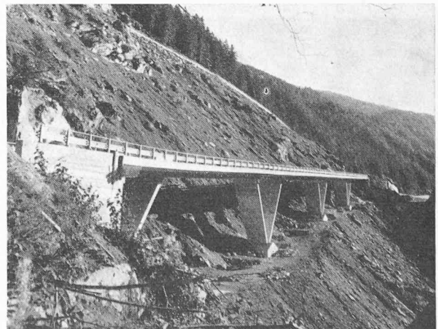
Fig. 1. — Vue d'ensemble de l'ouvrage.
