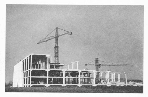
Fig. 20. — Entrepôt de « La Placette » à Bussigny. Vue sur l'ensemble des éléments durant le montage.
