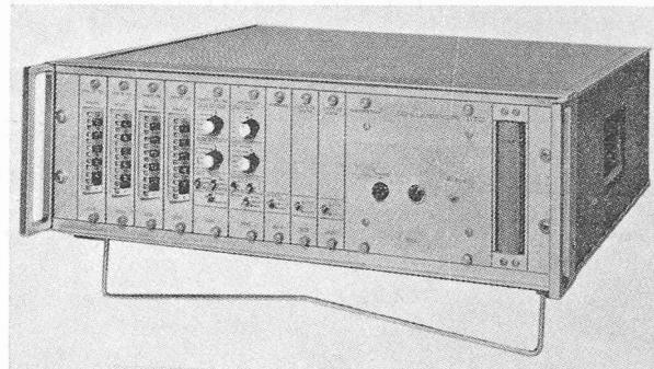
Le problème de l'adaptation des différents niveaux et logiques de sortie des voltmètres numériques a été résolu d'une façon très élégante avec un tiroir « interface » permettant la connexion de tous les appareils à sortie BCD.
