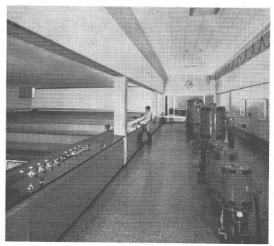
Installation de filtres rapides de Champ-Bougin, appartenant à la ville de Neuchâtel, pour le traitement d'eau du lac en eau potable. Capacité 1800 m³/h.
