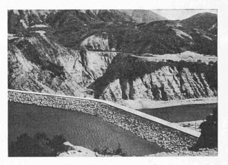
Fig. 43. — Digue de Serre-Ponçon. Vue du parement amont.
