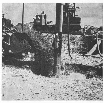
Fig. 7. — Maintien du niveau superficiel par l'apport de matériaux appropriés.
