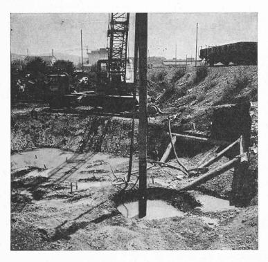
Fig. 6. — Formation d'un entonnoir à la surface du terrain, par suite de la diminution de la porosité.
