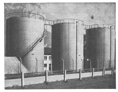
Installation de stockage des CFF à Saint-Maurice. Deux couches de PASSIVOL au minium de plomb et deux couches d'INERTOL 82 gris vert.
