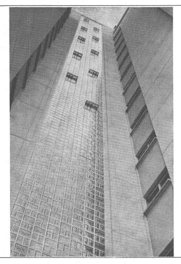
Vitrage en béton armé translucide de grande hauteur (45 m env.) sans entretoises - système breveté Solution esthétique et pratique des vitrages/cages d'escalier des immeublestours.
