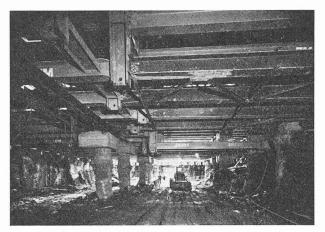
Fig. 17. — Transport par chargeuse. Photo Boissonnas, Genève.
