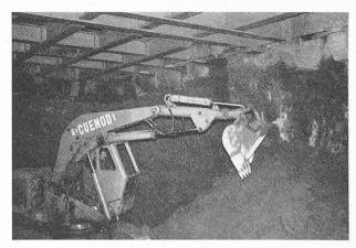
Fig. 16. — Pelle hydraulique sous la charpente.
