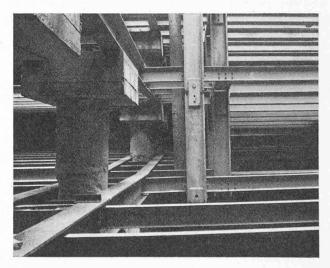
Fig. 26. - Poteaux «balanciers » aux sous-sols.
