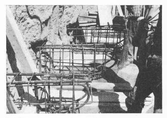
Fig. 33. — Armatures des consoles.
