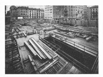
Fig. 24. — Vue générale d'un plancher.
