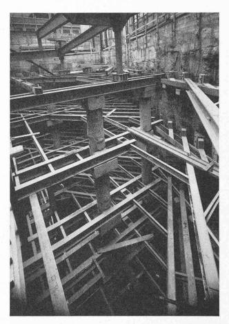
Fig. 27. — Pieux provisoires, poteaux définitifs sur appuis provisoires.
