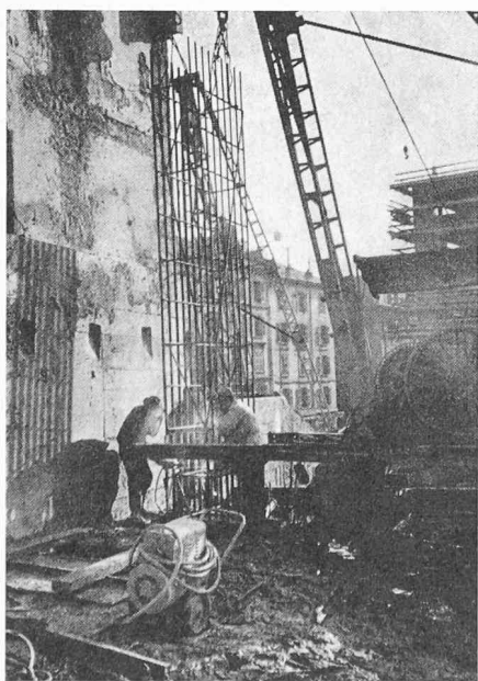
Fig. 11. — Soudure des paniers d'armatures.
