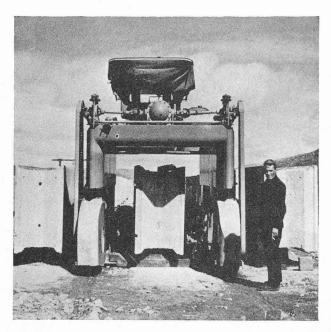
Fig. 4. — Engins de transport des voussoirs des voûtes.
