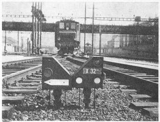
Fig. 23. — Signal nain de manœuvre, à trois indications : « Halte », « Avancez », « Avancez jusqu'au prochain signal
