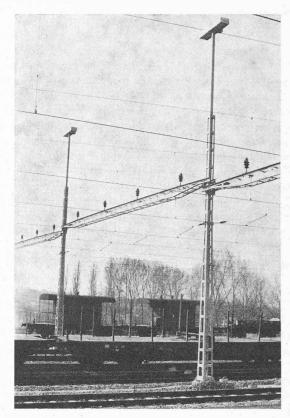
Fig. 28. — Ligne de contact du type normal, avec pylônes combinés pour l'éclairage et jougs.
