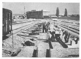
Fig. 10. — Pose de la voie dans le faisceau de formation.
