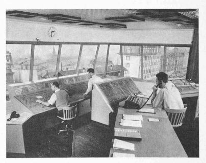
Fig. 21. — Vue générale du poste directeur de Lausanne-gare et du pupitre de commande des aiguilleurs.
