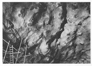
Fig. 12. — Aspect définitif de la calotte, après fin des travaux de soutènement au moyen de tirants en rocher et de béton projeté. On reconnaît, entre les têtes d'ancrage, le réseau des trous de drainage.
