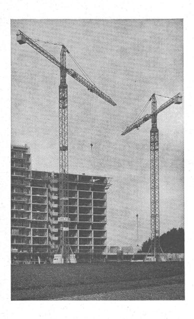
Montage hydraulique, sans aide auxiliaire. La commande à distance permet de diriger la grue d'un endroit quelconque.
