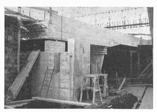
Fig. 2. — La culée « est », avec le pont-rail reposant sur des cales provisoires au droit des piles intermédiaires.
