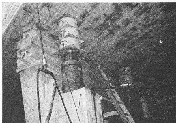
Fig. 3. — Vérinage du pont-rail reposant encore sur les cales en bois au sommet des piles intermédiaires. Les vérins de 250 t s'appuient sur des piles provisoires en béton.
