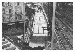
Fig. 1. — Vue à vol d'oiseau du pont-rail en position surélevée. On distingue les extrémités des câbles longitudinaux et les deux paires de câbles verticaux d'ancrage des culées.
