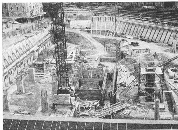
Fig. 5. — Etat du chantier, en cours d'exécution des sous-sols. On distingue le mur côté voies et le mur autostable le long de l'avenue d'Ouchy avec butons obliques.
