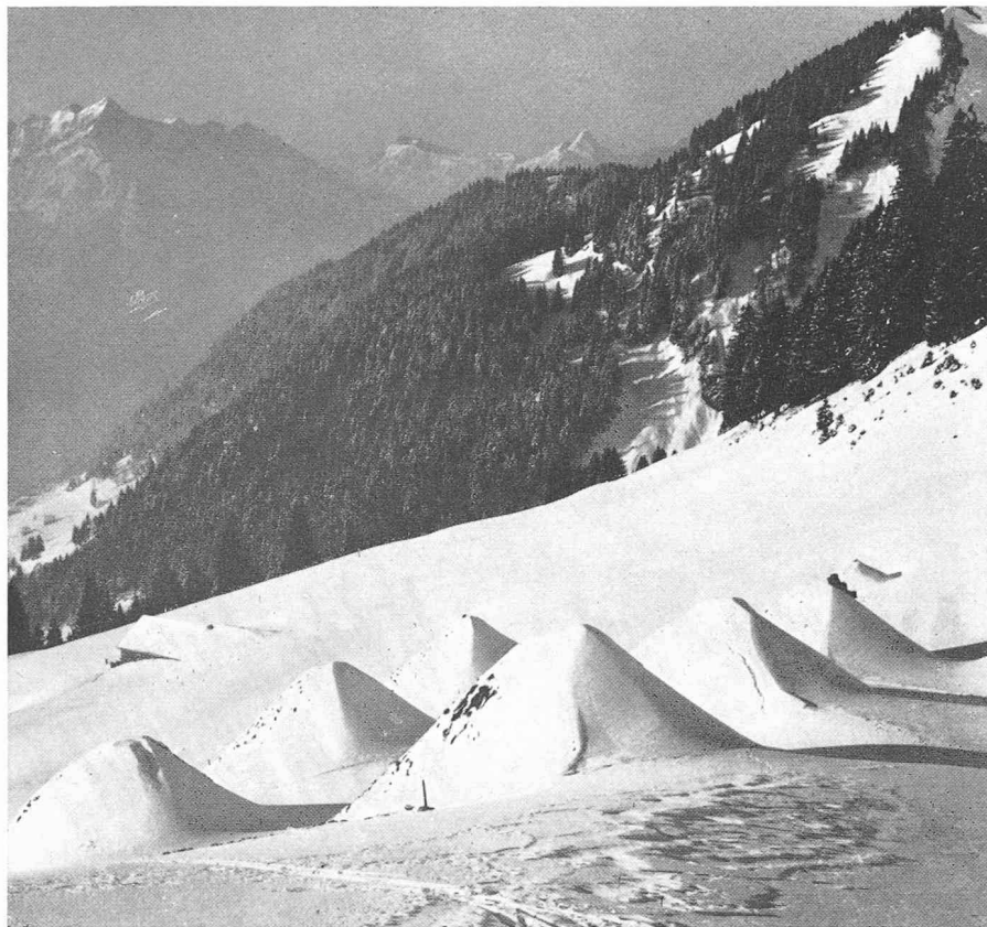
Freins d'avalanches constitués par des monticules artificiels en terre. Photo H. Frutiger, Institut fédéral pour l'étude de la neige et des avalanches, Weissfluhjoch.
