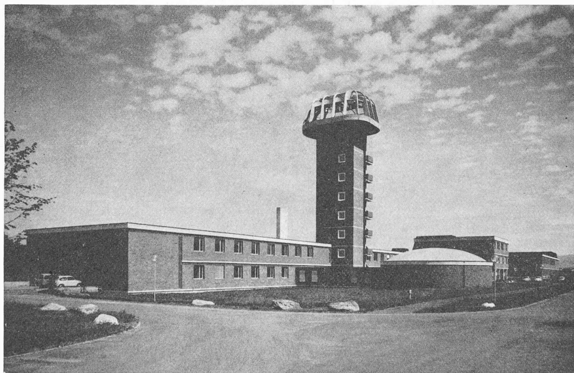
Fig. 5. — Vue de l'entrée principale.
