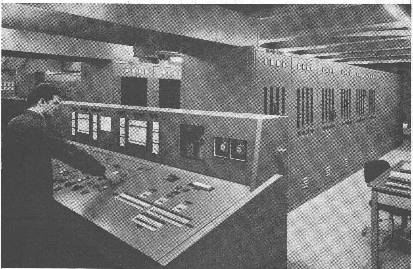
Vue partielle de la centrale avec le pupitre de commande, le tableau de climatisation, les 2 tableaux de distribution générale force et éclairage.
