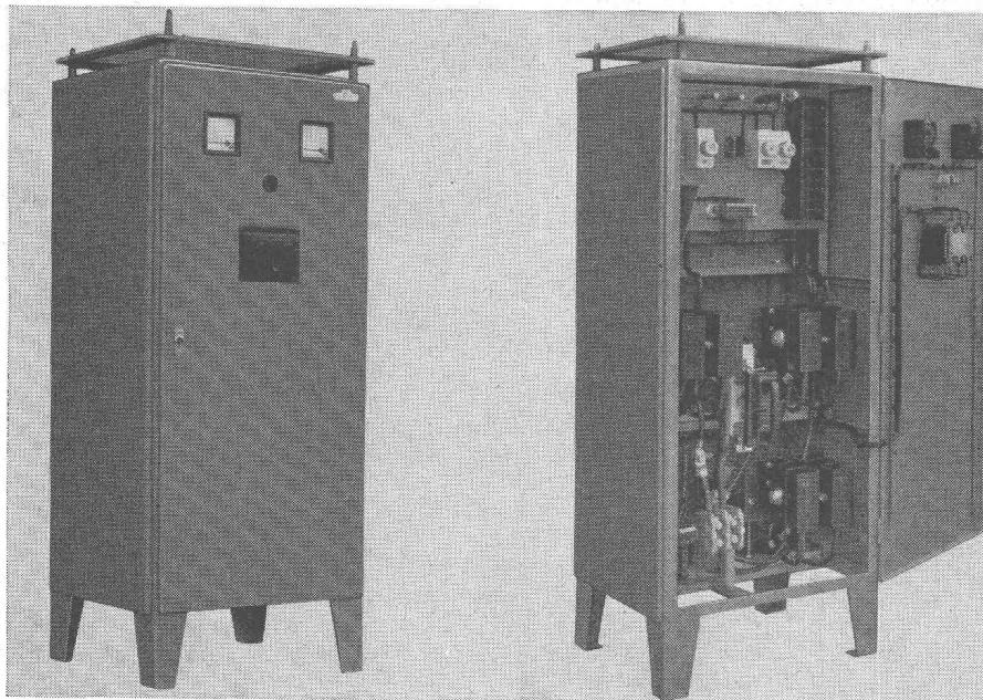
Les redresseurs Stabilomat GUTOR, équipés de thyristors, sont utilisés aussi bien pour l'alimentation directe des réseaux à courant continu sans batteries que pour des circuits de secours avec accumulateurs chargés en tampon.
