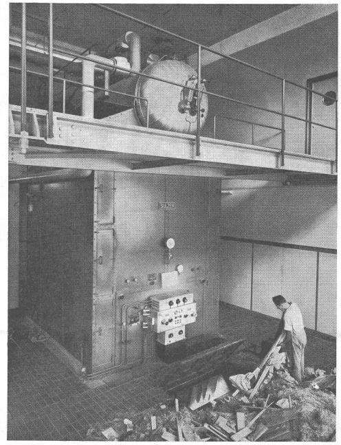
Chaudière à rayonnement du type C, chauffée au mazout et équipée d'un foyer pour la combustion de déchets. Cette chaufferie, installée dans une usine de construction mécanique, comprend deux autres chaudières à rayonnement du type C. Ces trois chaudières sont prévues chacune pour une puissance maximum, en service continu, de 5 t/h et une pression de 13 kg/cm².
