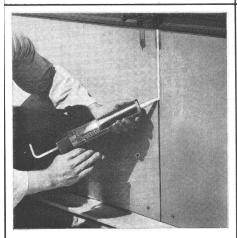
En bouchant les crevasses dans le mur d'une façade, on s'assure une protection contre les intempéries, insensible aux attaques de l'humidité et de la pluie
