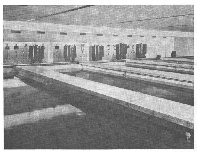
Installation de filtres rapides pour l'alimentation en eau de la ville de Genève. Bassins filtrants d'une surface totale de 280 m² pour un débit de 1620 m³/h. A l'arrière-plan, les moteurs de commande pour les pompes à eau brute et à eau potable.
