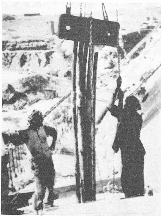
Fig. 4. — Tirants longs de 1000 t. Renforcement du mur de pied du barrage de Bou-Hanifia (Algérie).
