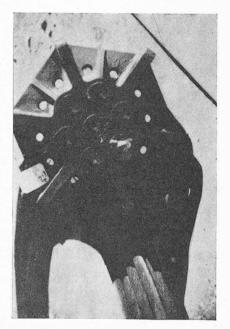
Fig. 10. Tête de câble de 1000 t en acier coulé, système Imbault. 1938.
