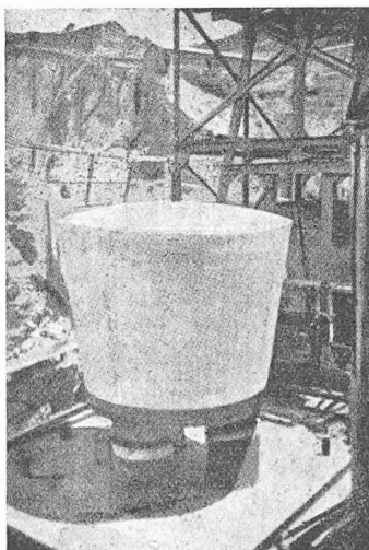
Fig. 3. — Tirants longs de 1000 t. Système Coyne. Renforcement du barrage de Cheurfas (Algérie).
