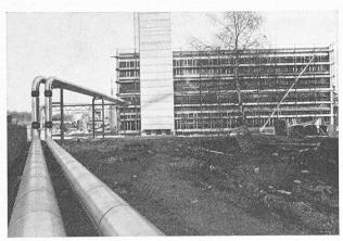
Fig. 13. — Vue des tuyauteries de distribution de chaleur avec, à l'arrière-plan, la cité du Lignon.
