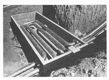
Fig. 17. — Vue d'une chambre de «lyre» de dilatation des tuyauteries.
