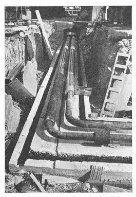
Fig. 15. — Vue des conduites d'eau surchauffées du Lignon lors du montage de l'isolation.
