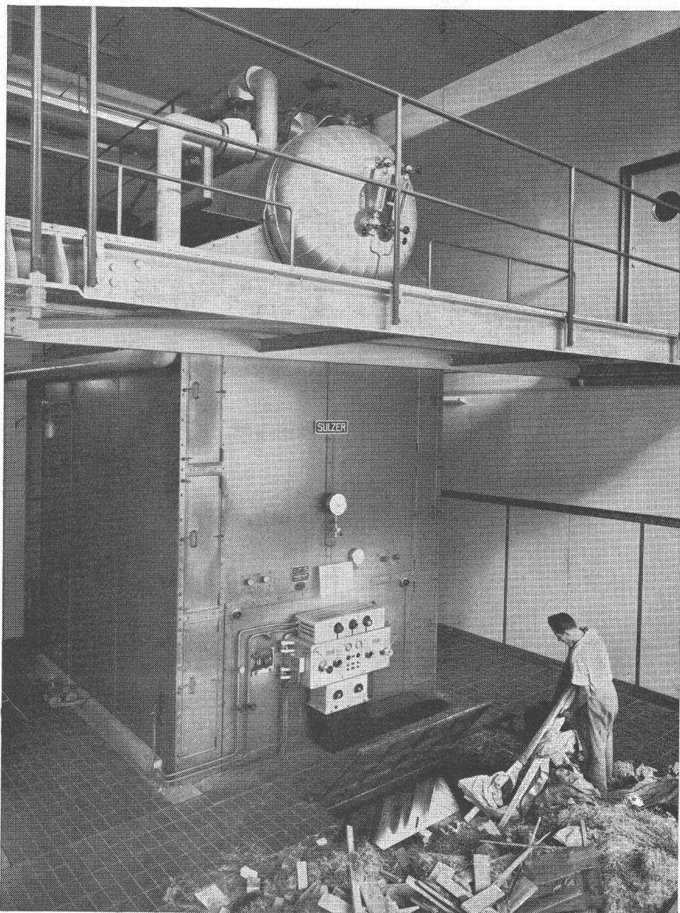
Chaudière à rayonnement du type C, chauffée au mazout et équipée d'un foyer pour la combustion de déchets. Cette chaufferie, installée dans une usine de construction mécanique, comprend deux autres chaudières à rayonnement du type C. Ces trois chaudières sont prévues chacune pour une puissance maximum, en service continu, de 5 t/h et une pression de 13 kg/cm<sup>2</sup>.
