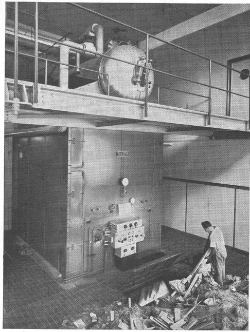
Chaudière à rayonnement du type C, chauffée au mazout et équipée d'un foyer pour la combustion de déchets. Cette chaufferie, installée dans une usine de construction mécanique, comprend deux autres chaudières à rayonnement du type C. Ces trois chaudières sont prévues chacune pour une puissance maximum, en service continu, de 5 t/h et une pression de 13 kg/cm².
