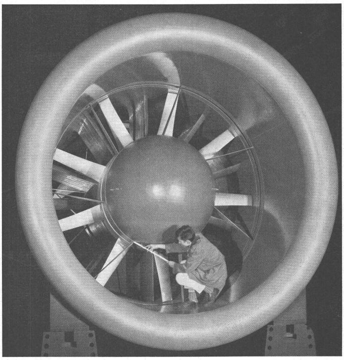
Ventilateur axial Exécution horizontale, diamètre de roue 2,8 m
