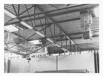
Fig. 8. — Vue du plafond d'un atelier. A gauche: un aérotherme de roulement (chauffage); au centre: installation d'extraction des gaz d'échappement; à droite: aérotherme d'air frais (venti-
