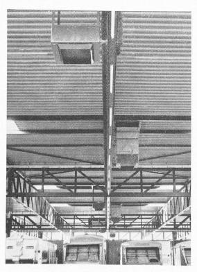
Fig. 3. — Vue partielle du hangar. A gauche: les aérothermes de roulement (chauffage); à droite: les aérothermes d'air frais (ventilation).
