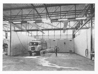
Fig. 4. — Vue d'un boxe de lavage. En haut: trois panneaux rayonnants; au fond: les grilles d'extraction d'air vicié.
