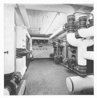
Fig. 2. — Vue de la chaufferie. A droite: les trois chaudières, au fond les trois vases sous pression.
