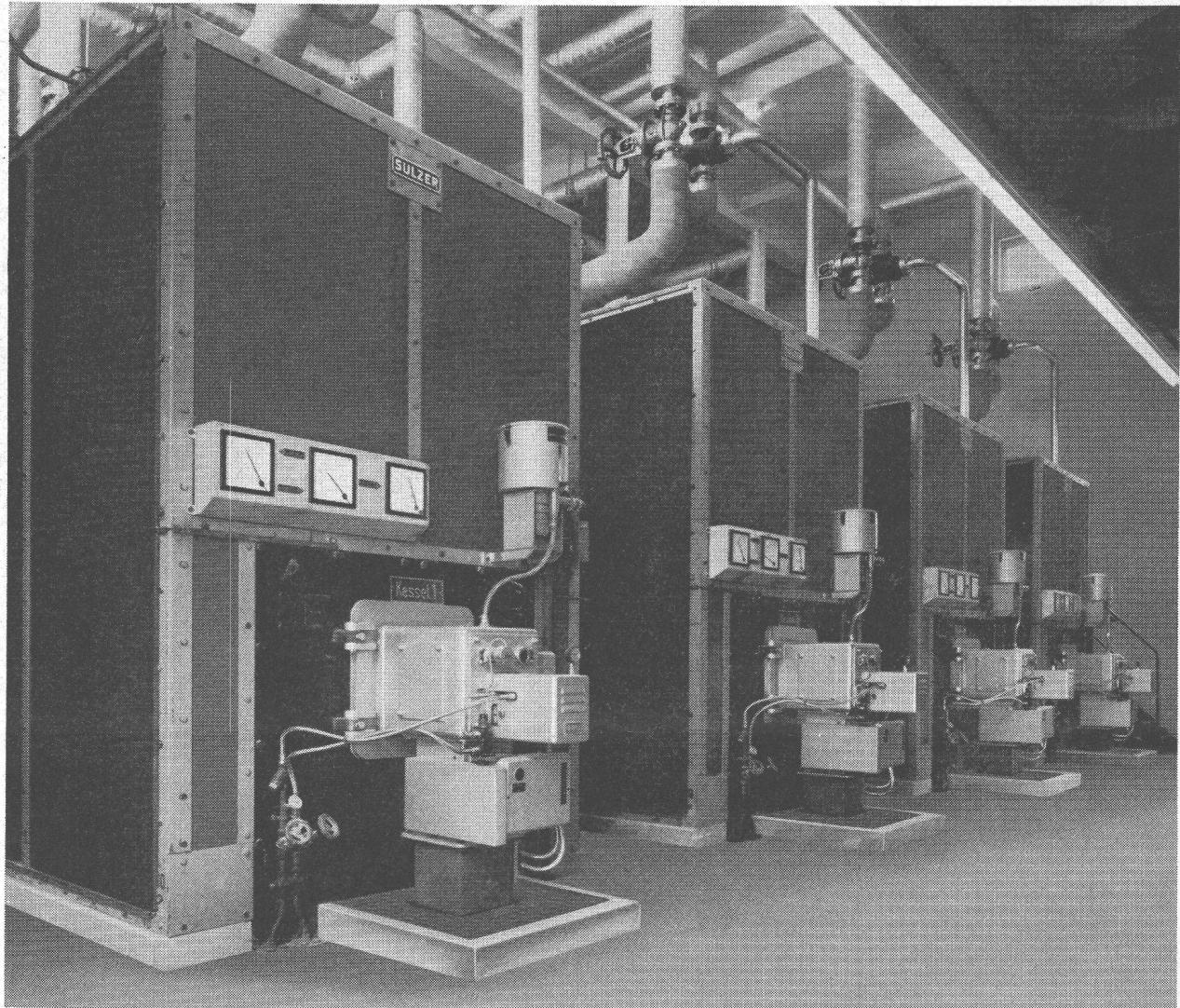
pour eau surchauffée et eau chaude jusqu'à une pression de service de 20 kg/cm<sup>2</sup> et puissances thermiques de 0,5 à 10 millions kcal/h, convenant pour la combustion de mazout, de charbon non frittant, de coke, de bois, de déchets et de gaz d'éclairage.
