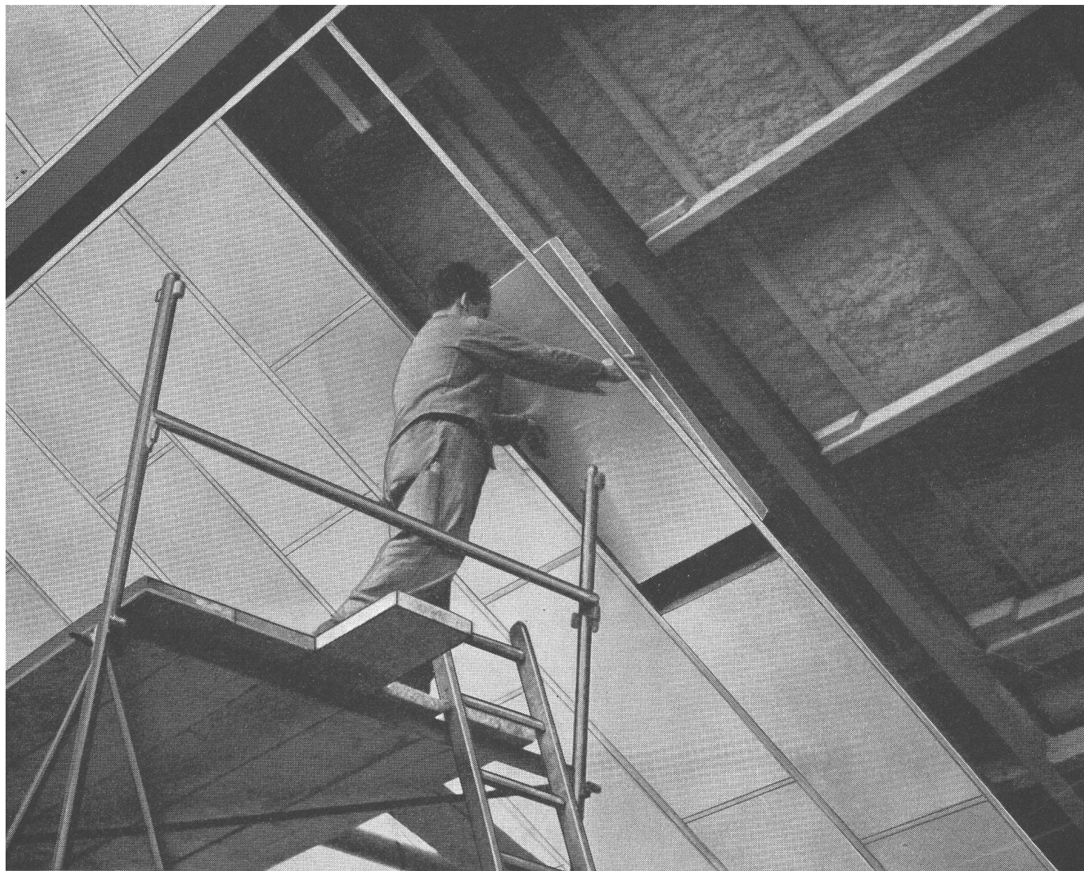
Plafond de local industriel avec panneaux en fibres de verre Vétroflex revêtu une face aluminium, type Shedisol
