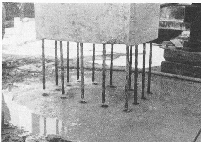
Fig. 12. — La base d'un pilier en cours de montage.
