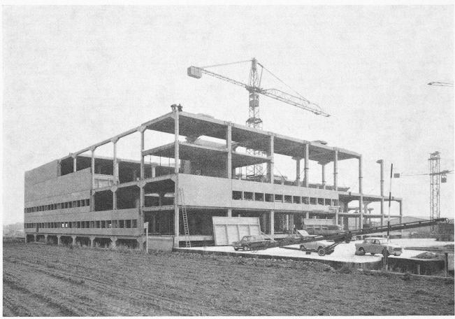
Fig. 16. — Vue générale du chantier. Au premier plan, un panneau de façade dont on distingue la disposition des nervures
