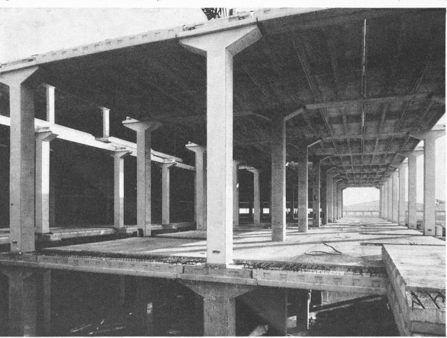
incorporés. Ces panneaux sont suspendus librement aux piliers par des assemblages métalliques démontables.
