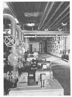
Fig. 2. — Au premier plan, les groupes moto-pompes du circuit d'eau des tours de refroidissement; au fond, les pompes du circuit d'eau glacée.
