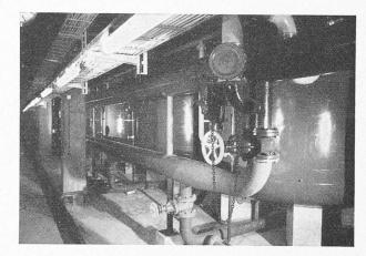
Fig. 8. — Les filtres à sable.
