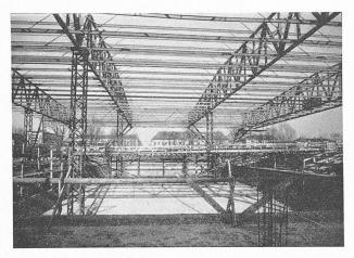
Fig. 6. — Structure métallique constituant le grand lanterneau
