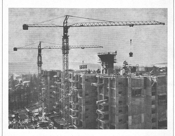
2500 grues par an. 40 modèles différents de 500 kg. à 15 t. Portées de 13,5 à 47 m. Standardisation absolue. Mécanismes en bain d'huile. Plus d'échange de moteurs. Sur demande, treuil permettant 20 vitesses différentes.
