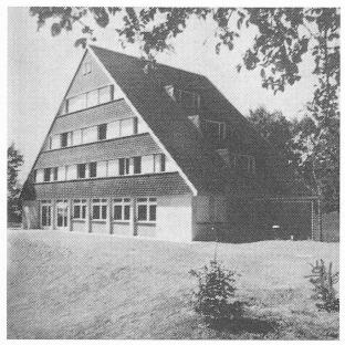
2. Home de vacances au bord du lac des Quatre-Cantons Le toit et la façade sont recouverts d'ardoises en amianteciment «ETERNIT» de couleur brune, en couverture double. La conception moderne de la construction reprend habilement les formes traditionnelles des éléments et s'harmonise parfaitement avec le paysage.
