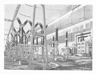
Fig. 2. — Usine de Chavalon — Poste 220 kV avec cordes aluminium.
